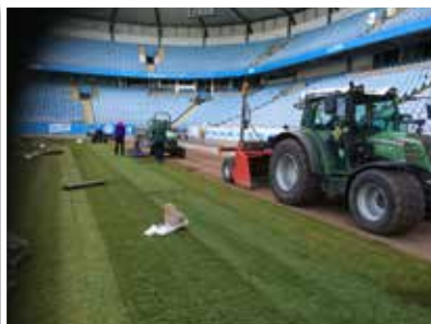
Läggning på Swedbank Stadion, Malmö
